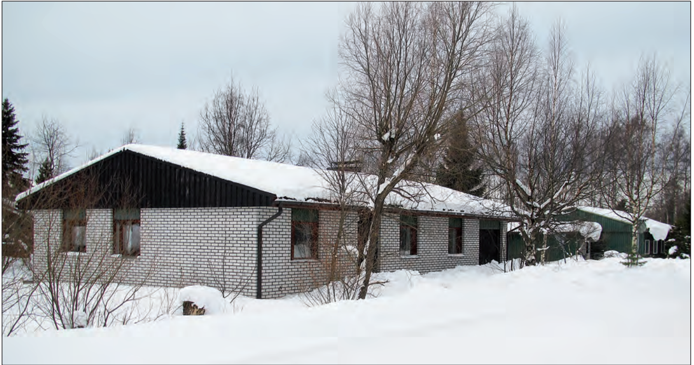
Omakotitalot olivat 1970-luvulla tyypillisesti matalia rakennuksia, joiden päätykolmiot olivat koteloituja. Muuramessa näitä taloja löytyy muun muassa Verkkoniemestä (kuvassa) ja Rättälistä.
