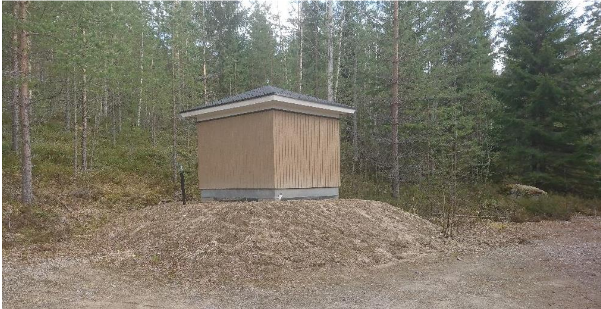
Kuva 7. Eräs Suuruskankaan pohjavesikaivoista.
