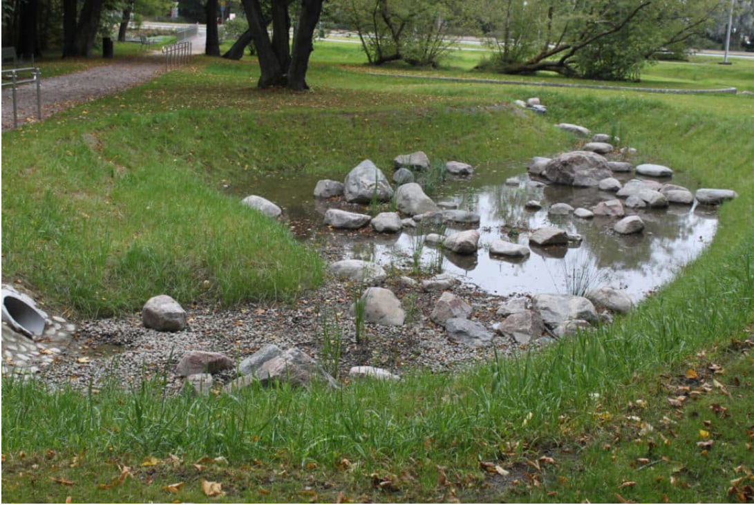
Kuva 11. Esimerkki hulevesipainanteesta (Kuva Seppo Närhi (käyttölupa), Vauhtitien hulevesipainanne, Helsinki)
