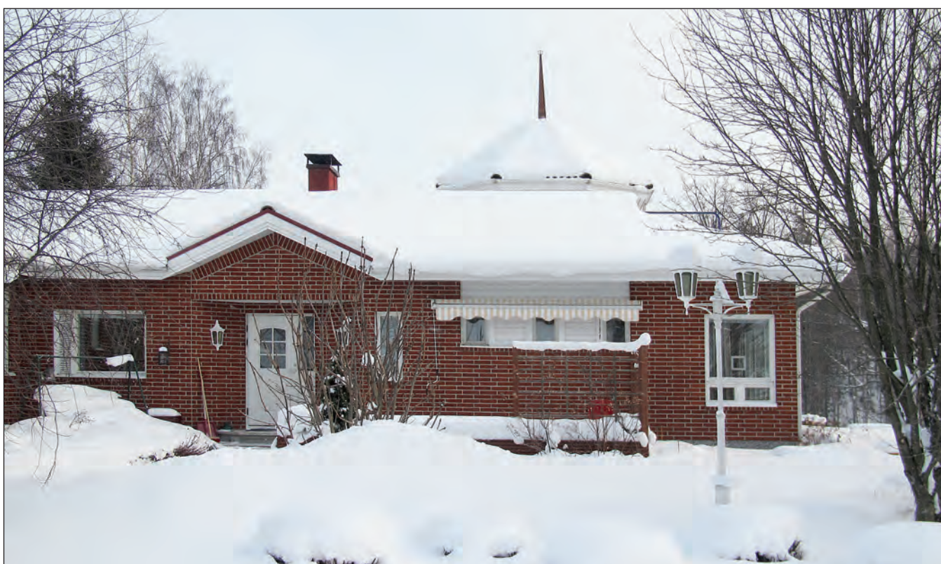
Punatiilestä tuli vuosikymmenellä yksi suosituimmista rakennusmateriaaleista. Pitkälän asuinalueen rakennuksissa näkyy myös suunnittelun muotokielen vapautuminen 1980-luvulla, joten rakennuksissa näkyy erilaisia erkereitä, muotoja ja torneja
