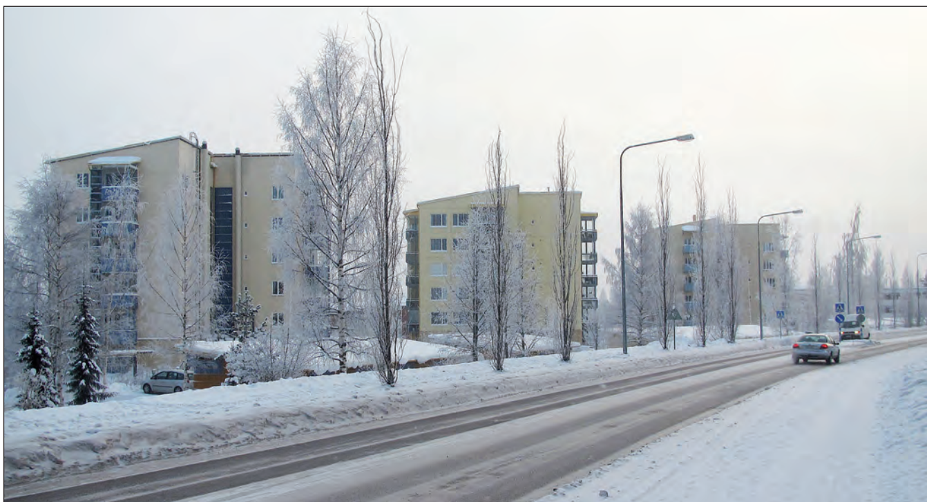
Muuramentien varren maisema muuttui 1990–2000-luvuilla, kun näkyvälle paikalle rakennettiin kolme pistemäistä kerrostaloa.
