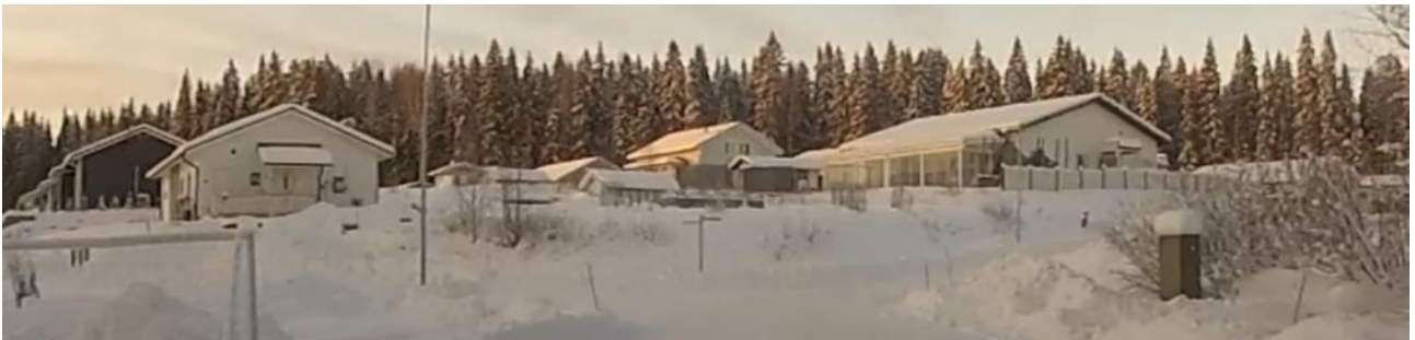
Kuva 19: Rakentunutta Seunavuoren laajennusosaa 2024.
