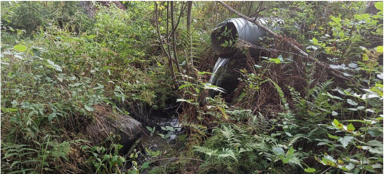
Kuva 16: Levonoja on putkitettu metsätien kohdalta Kuva: T. Makkonen 2023
